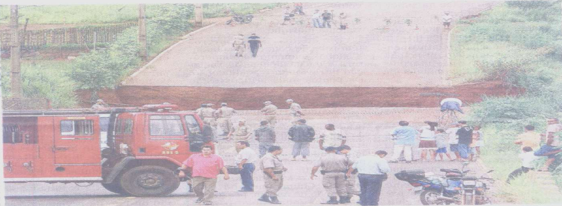
Bombeiros isolam buraco de 15 m de diâmetro na avenida Uirapuru, em Aparecida de Goiânia, região metropolitana de Goiânia
